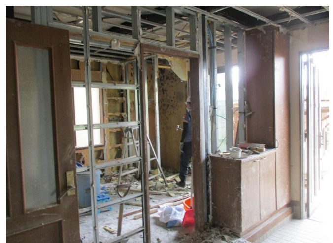
1か月が過ぎても壁(断熱材含む)やフローリングがそのまま。 内装を取ると黒いカビが全面に見えた。 解体技術のある大工さんが必要
