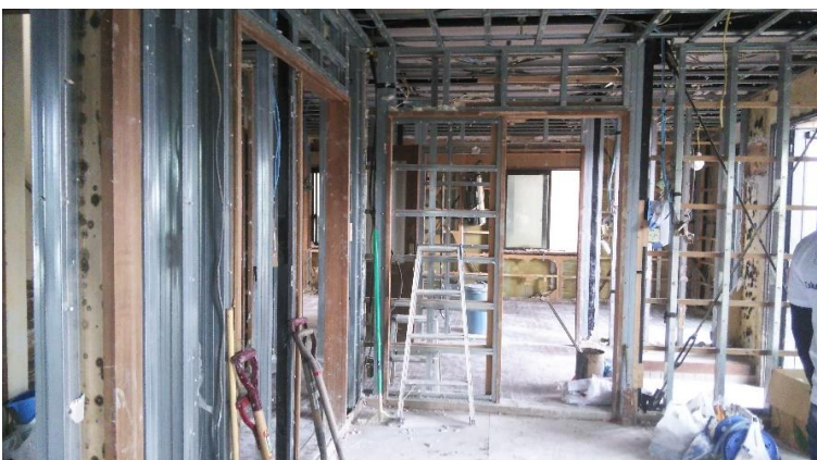
1か月が過ぎても壁(断熱材含む)やフローリングがそのまま。 内装を取ると黒いカビが全面に見えた。 解体技術のある大工さんが必要
